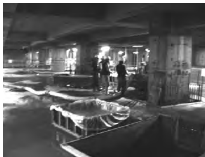
(d) Casting concrete
